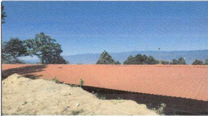
Foto1: Sustitución de Lamina por lamina troquelada aluzinc calibre 26
