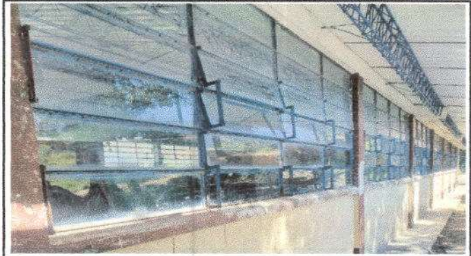
Foto 2: Sustitución de vidrios
